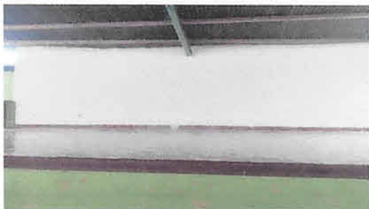
Foto 5: Pared mejorada y repellada.
