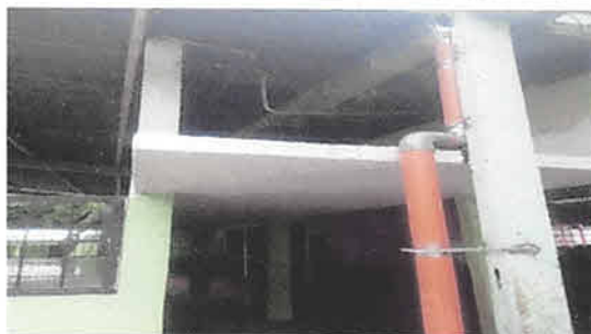
Foto 3: Tubería de bajada de agua cambiada.
