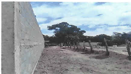
Foto 1: Área del Muro Perimetral, culminado.
